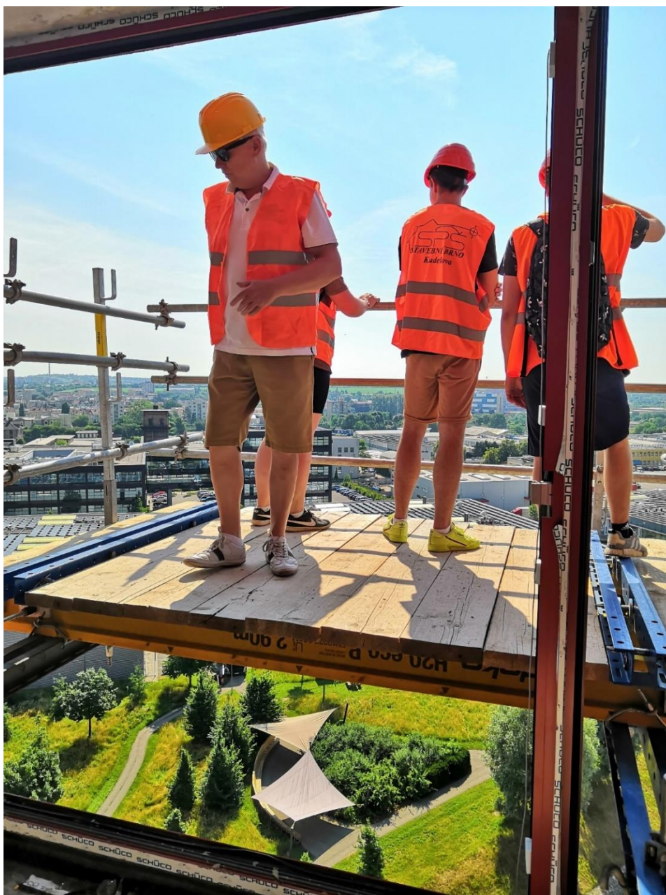
Studenti na exkurzi – výstavba nových bytových domů na Dornychu
